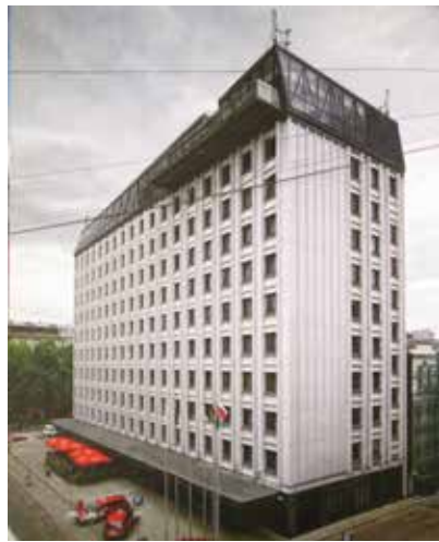
14. att. Administratīvā ēka Dzirnau ielā ir pārbūvēta par viesnīcu „Alberts”, tās dzelzsbetona korpusu vainagojot ar jaunu stiklotu stāvu. Foto 2008
