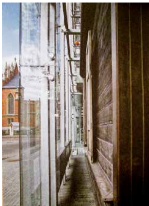
12. att. Ēka Rīgā, Baznīcas ielā. Zem stiklotās fasādes redzams koka apšuvums, ietverot arī nojauktās 19. gs. koka ēkas fragmentus
