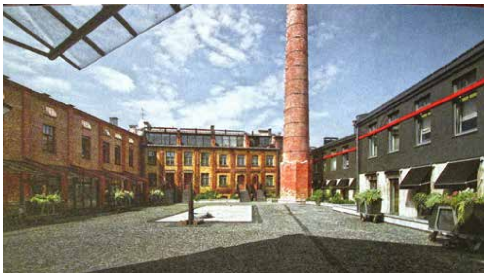
15. att. “Ģipša fabrikas” kvartāls Rīgā ir pārbūvēts mājokļiem, kā industriālās vēstures akcentu saglabājot skursteni, bet zem pagalma izbūvēta autostāvvietā. Foto 2008
