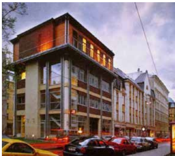
13. att. Biroju ēka Rīgā, Dzirnau ielā, tapa, pārceļot 19. gs. koka ēku uz jaunbūves jumta. Foto 2005
